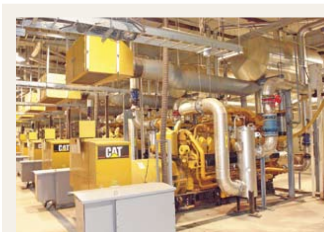
Os 16 grupos geradores CAT foram instalados em duas seções na planta termelétrica da Biogás-São João Energia Ambiental, na Zona Leste da capital paulista
