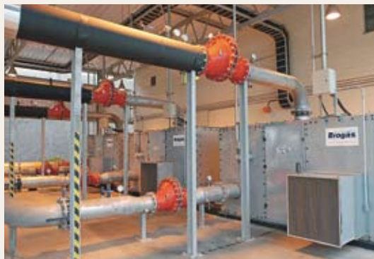
Ao chegar à usina, o biogás passa pelos processos de secagem e sopro centrífugo
