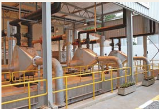
Ao chegar à usina, o biogás passa pelos processos de secagem e sopro centrífugo
