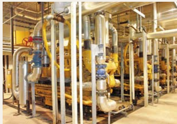
Os 16 grupos geradores CAT foram instalados em duas seções na planta termelétrica da Biogás-São João Energia Ambiental, na Zona Leste da capital paulista
